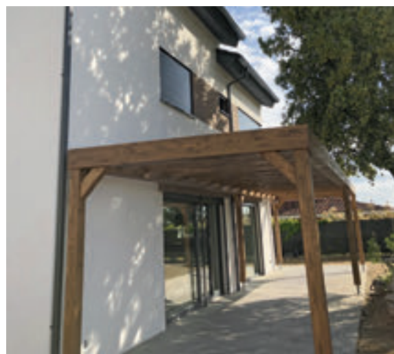
De arriba abajo, Casa Helios, Casa Jaral (detalle interior) y Casa Quercus © Anne Vogt.
