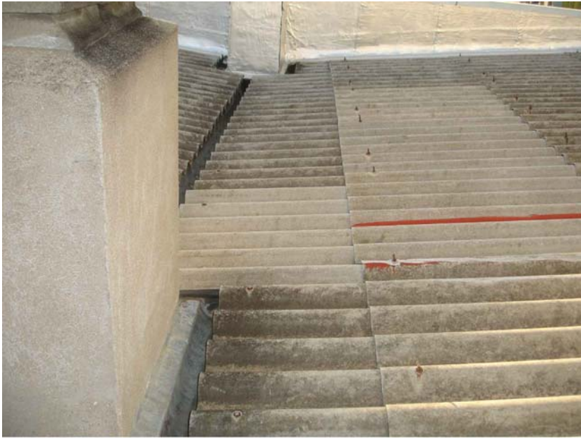
RETIRADA DE PLACAS DE FIBROCEMENTO Y SUSTITUCION POR PANEL SANDWICH DE 8 CM DE POLIURETANO.
