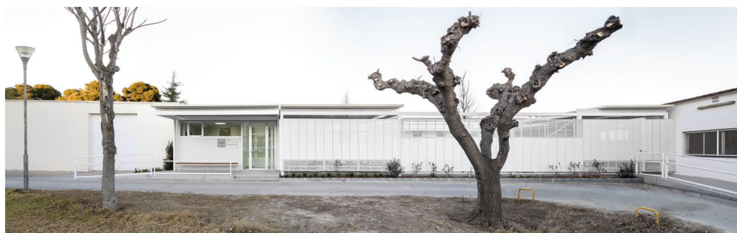
Façana d'accés principal (sud oest) Accés principal. El tancament de deployée regula la privacitat: protecció visual en l'àmbit dels porxos laterals i transparència en la zona de la piscina.
