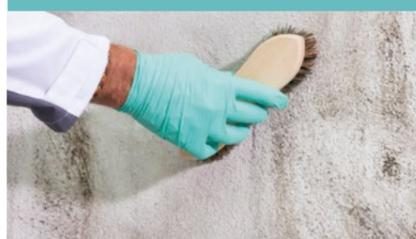
Los restos de suciedad en la superficie impiden la adherencia de pintura nueva.
