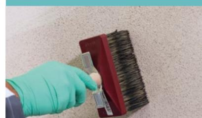
El sustrato no absorbe la pintura por igual en todas las partes, por ello la superficie del área pintada no es homogénea. Esto puede producir la pulverización o el desconchado de la pintura.
