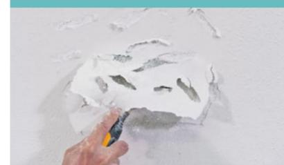
Antes de pintar, elimine el material desconchado o suelto. Rellene después la superficie irregular.
