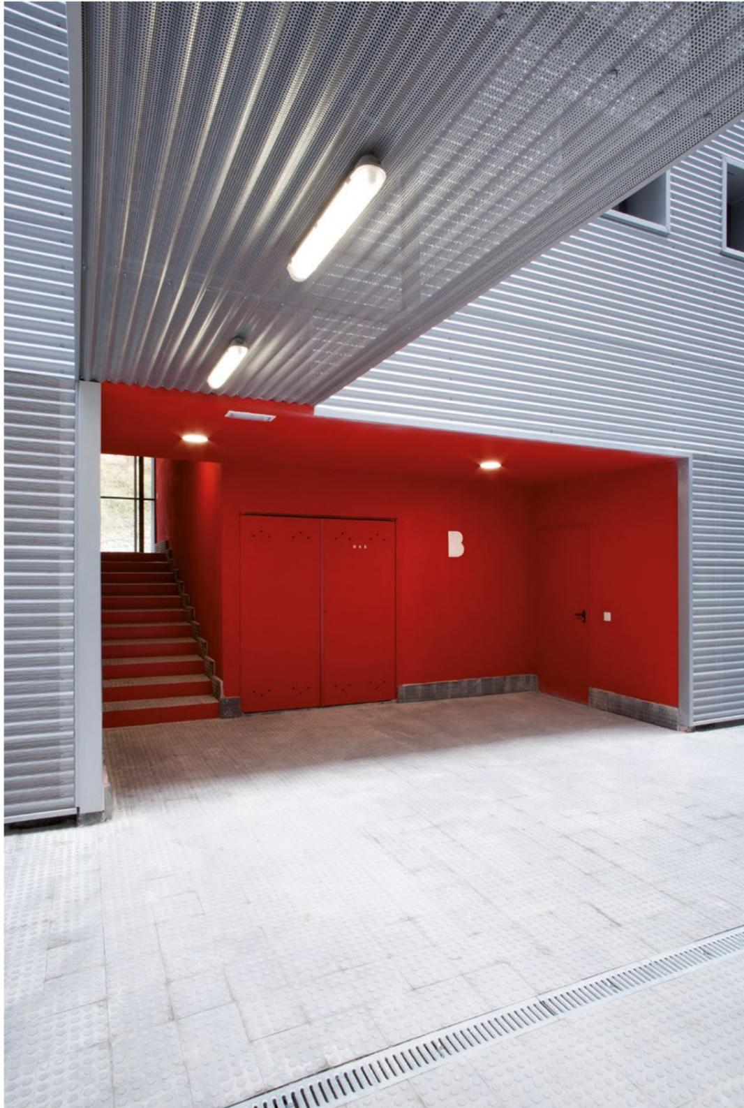
Las fachadas al patio se realizan con una solución de fachada ventilada con revestimiento metálico de chapa minionda gris. En la cámara de aire de 25 cm se introducen todas las instalaciones del edificio (extracción mecánica, calderas, bajantes, suministros de agua, gas...) que nutren a baños y cocinas de todas las viviendas.
