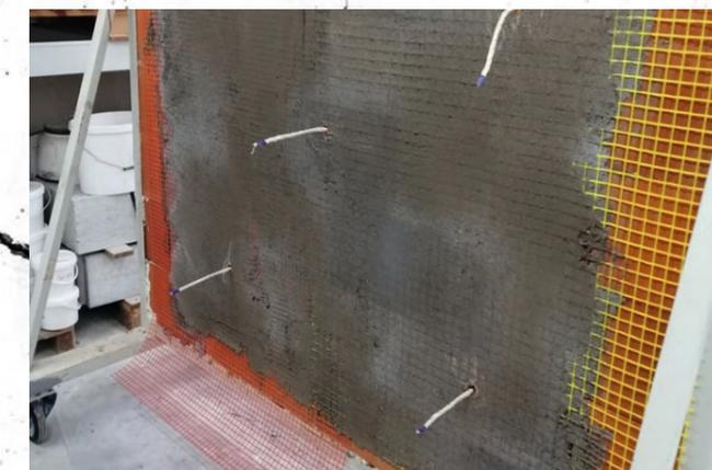
**Bildbeschreibung:** Verstärkung einer erdbebengeschädigten Wand mit Baunit NHL SicuroProtect Armierungsmörtel und Baunit SicuroTex. Das Armierungsnetz wird mit Baunit SicuroConector und Baunit SicuroFixator im Untergrund verankert.
